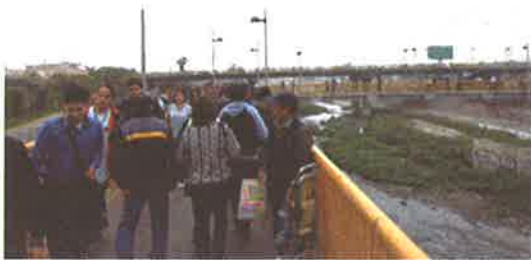
Figura 7. Visitas e inspecciones previas en puente Rayitos de Sol
