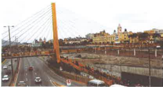
Figura 8. Vista general del Puente Rayitos de Sol.
