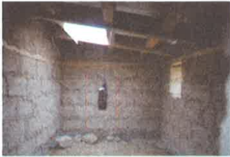
Figura 3. Termohigrómetro instalado dentro del módulo de vivienda.
