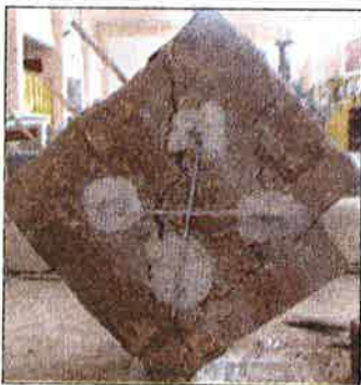
Foto N°21: 3er murete luego de aplicarle la carga vertical donde se observa la falla por corte diagonal en las juntas.
