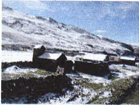
Foto N°13: Vivienda de adobe con techos de paja, expuestas a la sobrecarga por el peso de la nevada.
