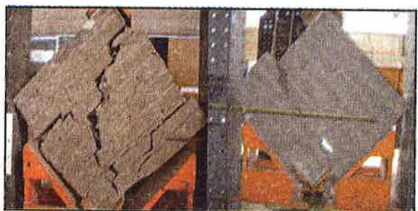
3) Falla de corte diagonal en bloques y juntas 4) Falla de corte por deslizamiento bloques y juntas
