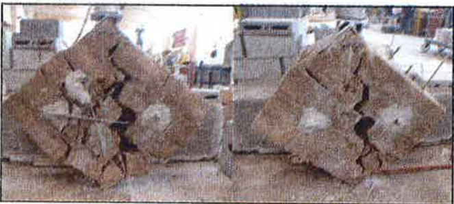
Foto N°20: 1er y 2do murete luego de aplicarles la carga vertical, donde se observa en ambos casos la falla por corte diagonal en las juntas.
