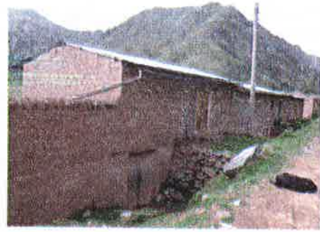
Foto N°14: Vivienda de adobe con techo de calamina y su canaleta (Comunidad de Pampa Phalla)
