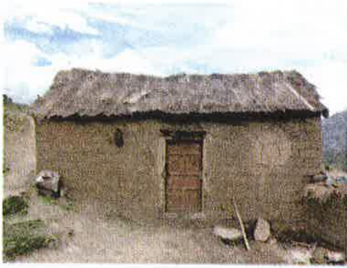
Foto N°12: Vivienda de adobe con techo de paja (Comunidad de Pujio Pujio)
