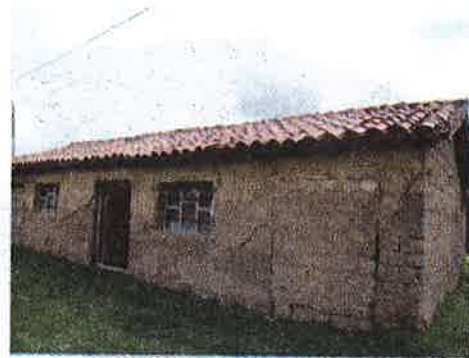
Foto N°15: Vivienda de adobe con techo de tejas
