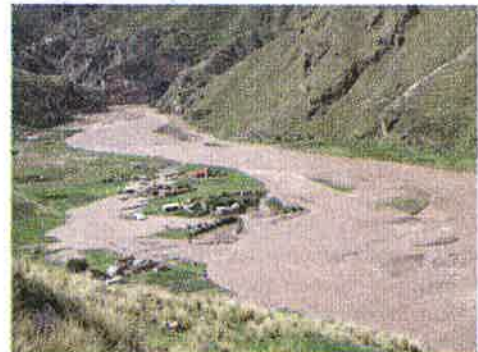
Foto N°4: Viviendas ubicadas al margen del río Salq'a (centro poblado de Santa Bárbara)
