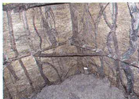
Foto N°11: Estructura interna de la vivienda de adobe con techo con paja.
