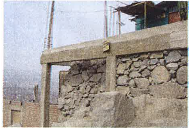
Fig. 4.a. Columnas cortas y largas en proceso de construcción.
