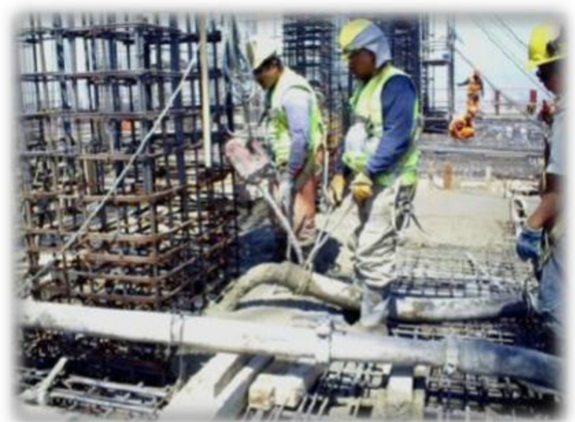
Foto N°1: Vaciado de concreto en losas macizas
