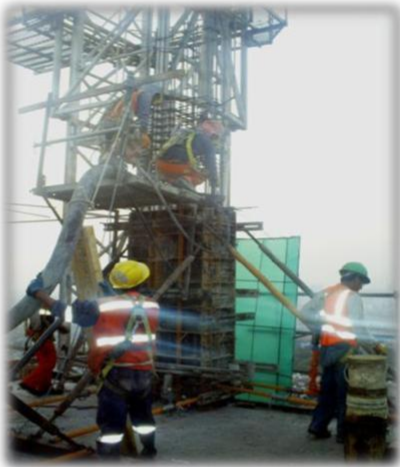
Foto N°2: Vaciado de concreto en columnas
