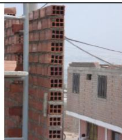
Fig. 2. Muro de albañilería tubular
